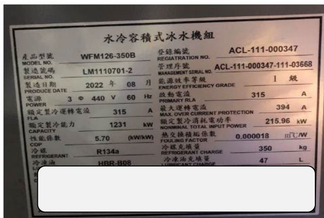
冰水機組銘牌照片
